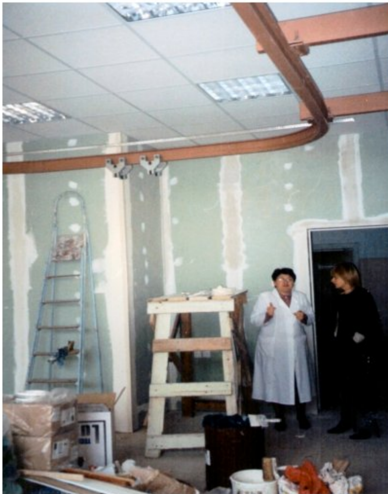
Gymnastikraum des Frühförderzentrums kurz vor der Fertigstellung
