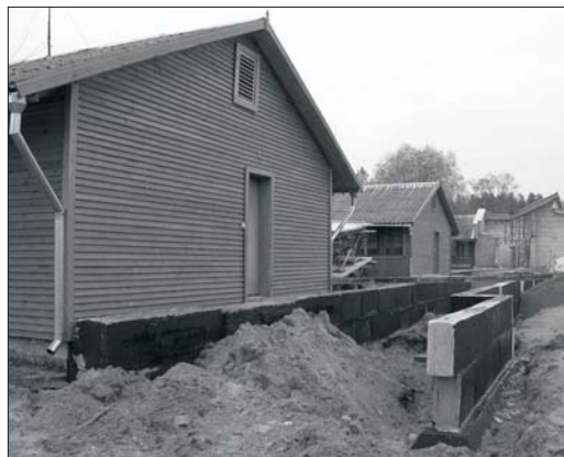
Sanierung eines Holzhauses
