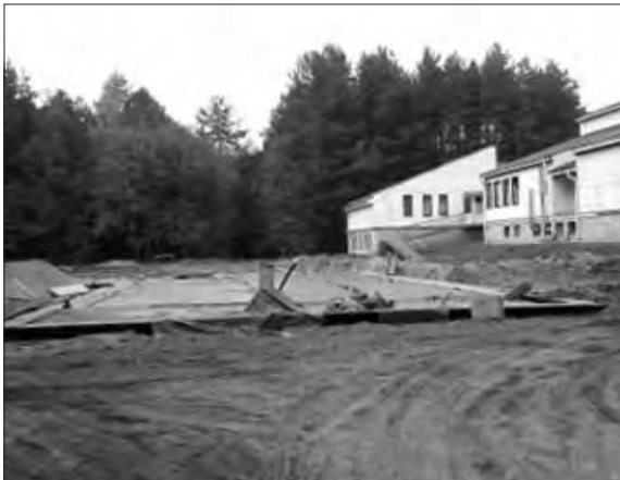
Die Fundamente sind gelegt. Neben dem HPZ baut der Oblast Pskow den neuen inklusiven Kindergarten - künftiger Lernort für Kinder und Erwachsene
